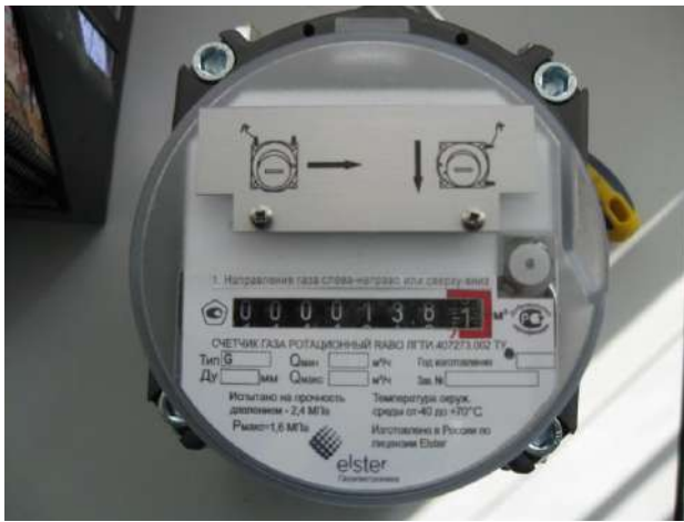
Рисунок 1. Счетный механизм С1Д
